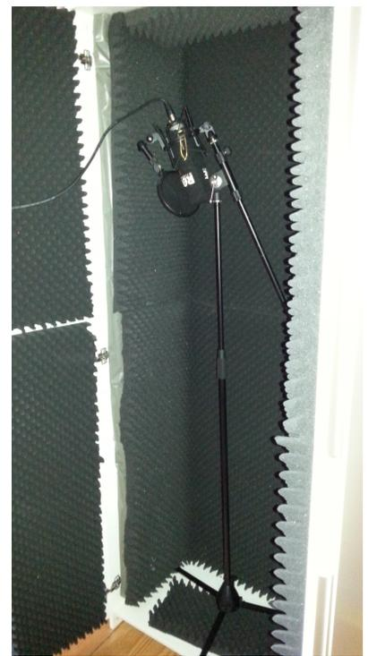
Zum Bau einer Heim-Sprecherkabine benötigt man einen einfachen Schrank. Steinwolle, Akustikschaumstoff, Folie, Tackerklemmen, Kleber und etwas handwerkliches Geschick.
